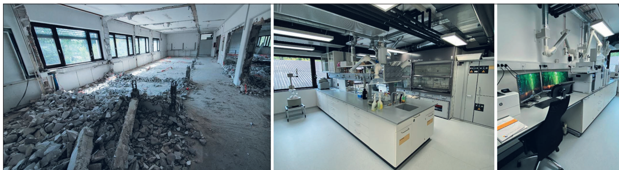
Slika 5. Prenovo prostorov 1. nadstropja stavbe B Oddelka za lesarstvo je predstavil Maks Merela; začetek gradbenih del v letu 2024 (levo) in prenovljeni laboratoriji v letu 2025 (sredina in desno).
