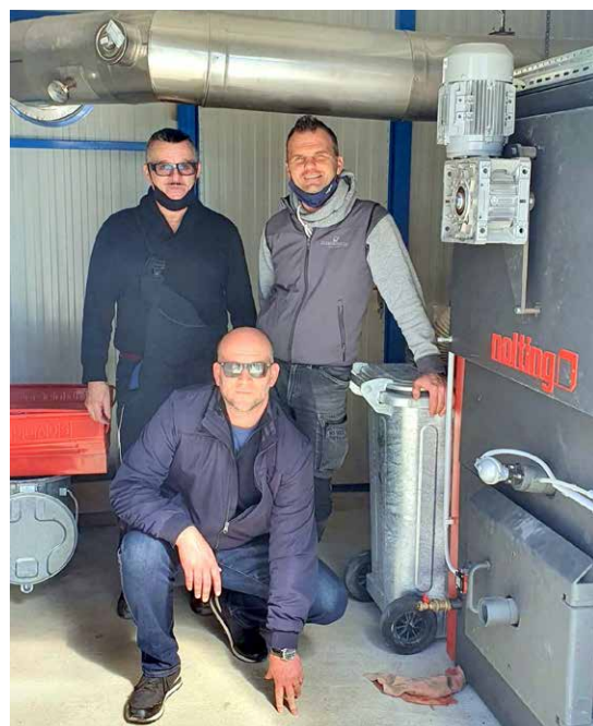
□ Kotlovnica s kotlom Nolting LCS-RU 215/270 kW pri stranki Elektrometal, Poreč, Hrvaška
