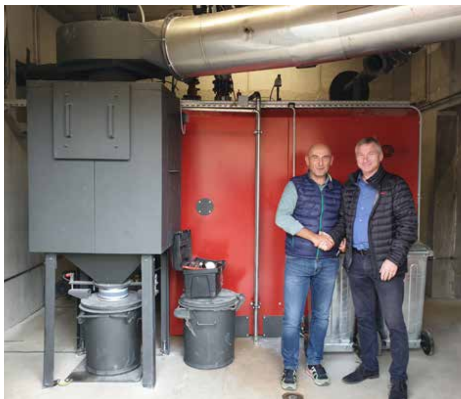
□ Kotlovnica s kotlom Nolting LCS-RU 400/450 kW in dimnikom Kam sistemi pri stranki Internova Pazin, Hrvaška
