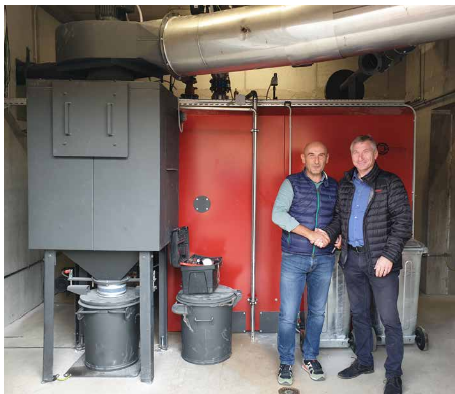
□ Kotlovnica s kotlom Nolting LCS-RU 400/450 kW i dimnjakom Kam sistemi u tvornici Internova Pazin, Hrvatska
