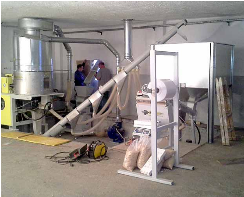
□ Linija za proizvodnju peleta P SYSTEM P 300 tijekom montaže u EXTRAFORM-u, Prestranek, Slovenija
