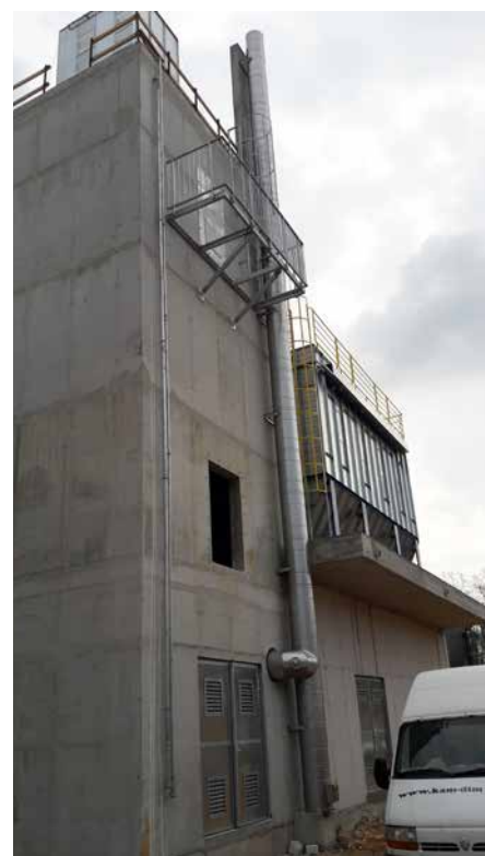
□ Kotlovnica s kotlom Nolting LCS-RU 400/450 kW i dimnjakom Kam sistemi u tvornici Internova Pazin, Hrvatska
